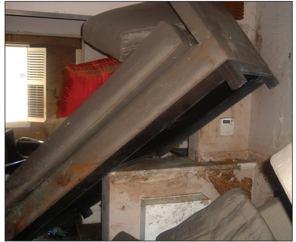
Figura 2. Los muebles apilados por las aguas de inundación generan un peligro de seguridad.
